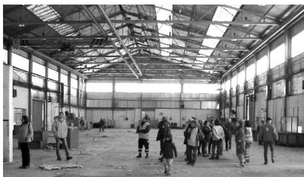
Interior de uno de los talleres de Corta Cervantes Este.
